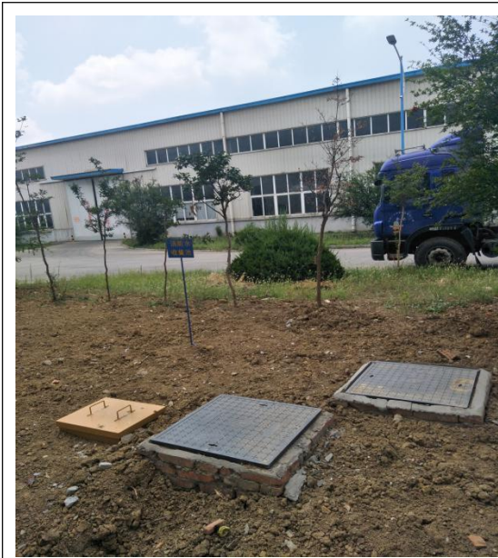
喷漆房边事故池
