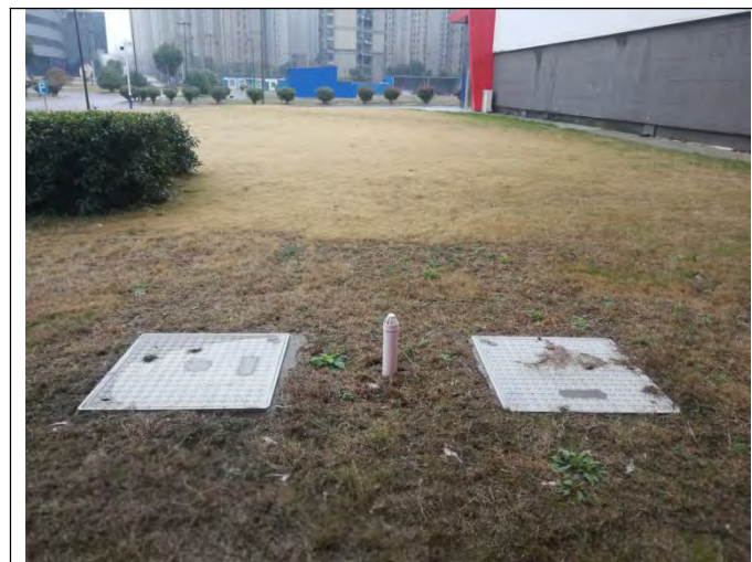
图 1 应急事故水池
