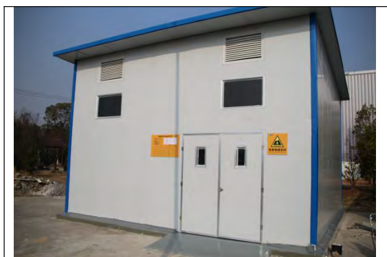
图 危废暂存间
